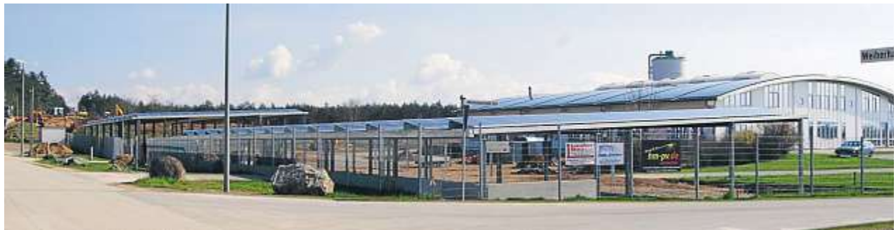
Die neuen Unterstellhallen werden mit Solarmodulen bestückt.
